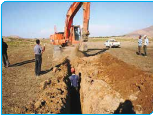
کندن زمین با بیل مکانیکی
